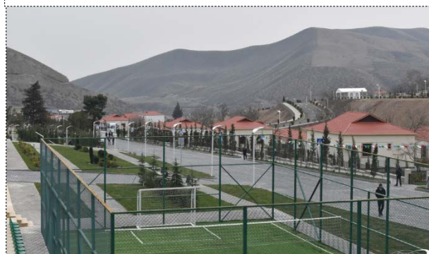
Photo 5. Village de Talich nouvellement reconstruit dans le district de Tartar.
